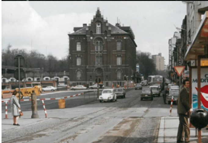
Alors en pleins travaux, la rue du Pont-Neuf laisse apparaître une partie de l'îlot du Collège du Sacré-Cœur avec, sur la gauche, l'entrée de la rue de Montigny (AVCC – fonds Jean Yernaux).
